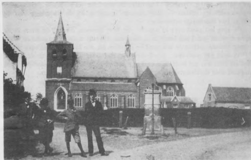
Boven: De Lambertuskerk vóór de verbouwing van 1911. De kerk kende toen maar een transept. In 1911 werd de kerk vergroot en de sacristie veranderd. Coll. Heemkudekring Rosmalen.
