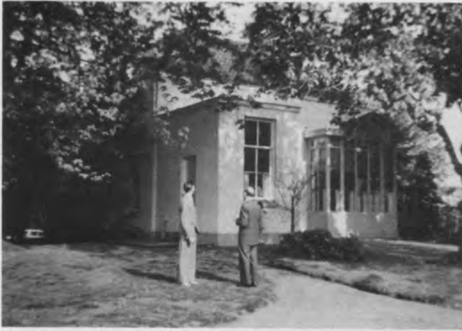
Hoogoord aan de zuidzijde voor de verbouwing.
