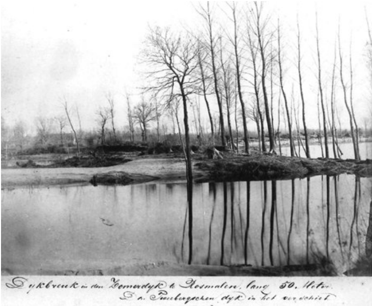
Dijkbreuk in den Zomerdijk te Rosmalen lang 50 meter Den Tweeberschen dijk in het verschiet (foto uit 1876)
