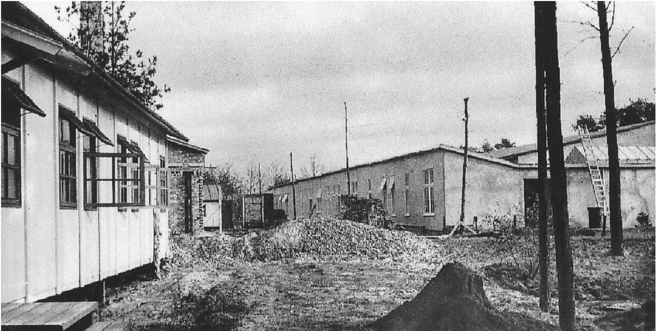
De eerste bouwwerkzaamheden op Maria Oord
