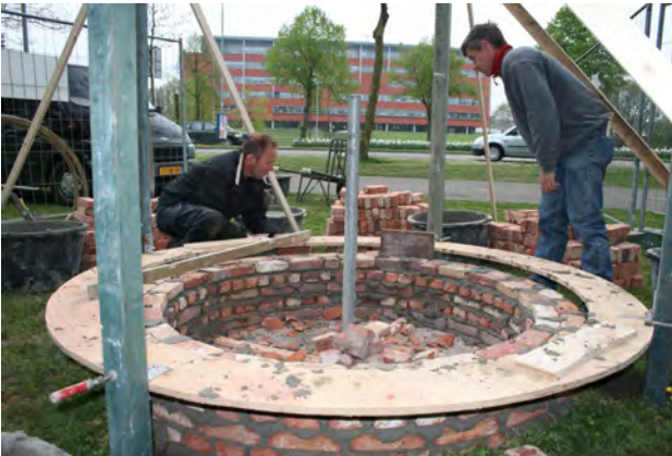
Afb 3; opmetselen van de stenen, 14 april 2011
