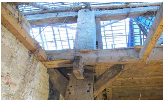
Buitenzijde van de rechter stijl van het vijfde gebint.
