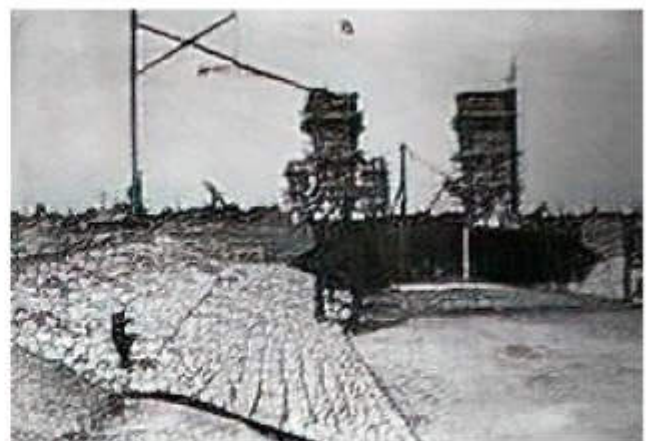
Werk aan de stuw en sluis bij Lith 22
